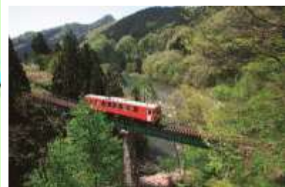
③荒瀬川橋梁(阿仁合～荒瀬)
