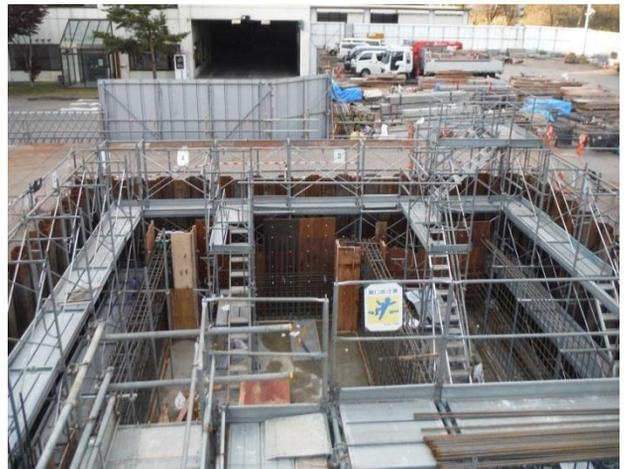
地下部分となる雨水貯留槽です。コンクリート打設のための施工をします。
