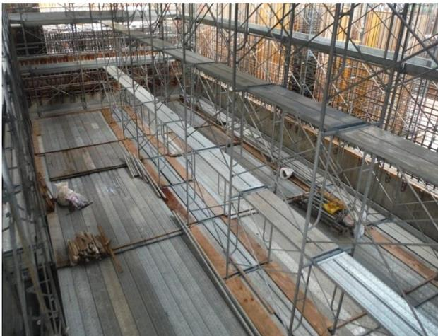
現在は足場ですが、この後、コンクリート打設のための鉄筋を組む作業(配筋)をします。
