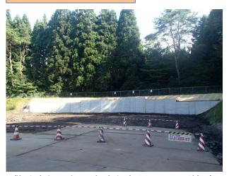
敷地南側に斜面崩壊を防ぐため、L型擁壁 (鉄筋コンクリート)を設置する工事を行い ました。
