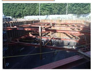
ごみピットの掘削が終わり、鉄筋を組み立て(配筋)しています。この後、コンクリートを打設します。
