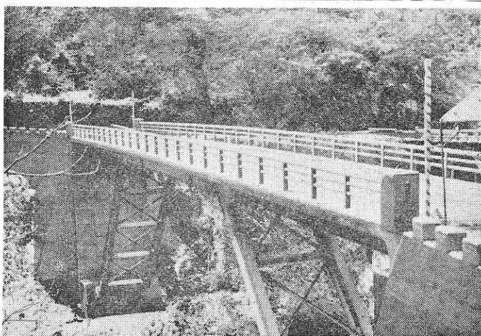
竣工なつた幸屋橋
