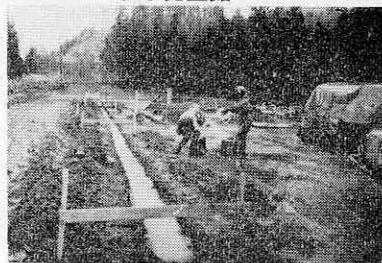
邦栄通信(御蔵町営住宅後)
