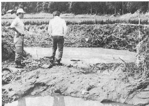
〔欠かいた堤防と、手前はすっかり土砂に埋まった水田。冷害に追いつけをかけるように、9月3日の局地的豪雨は、1.7haが冠水し、約900万円の農業災害を発生させた。(吉田地区で)〕
