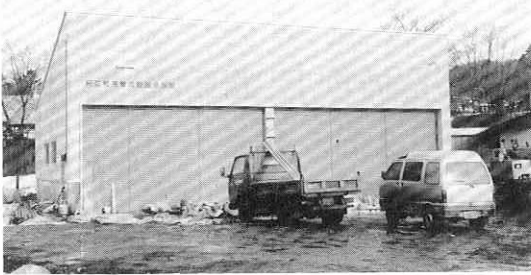
▶ 駅前に完成した克雪センター
