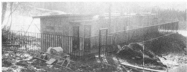
還元融資を受けて建設された高津森地区の水道施設
