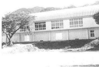
改修工事の終わった「一中体育館」
