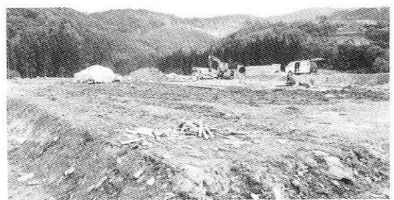
宿泊施設第1号の工事が進む高津森
