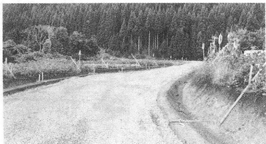
順調に工事の進む「阿仁線」
