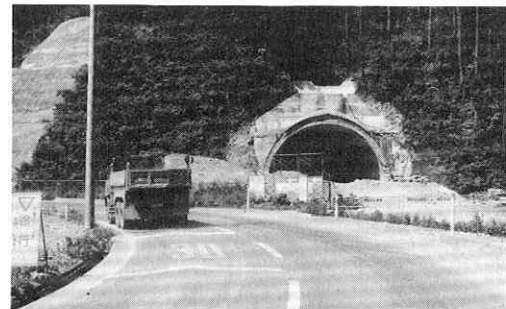
貫通したバイパスのトンネル
