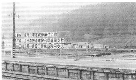
順調に進められている工事
