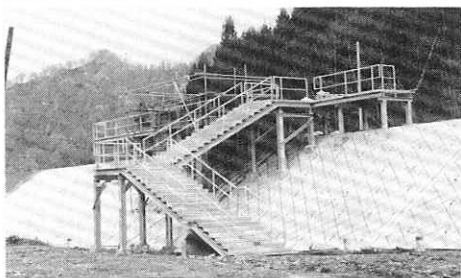
工事の進む「奥阿仁駅」の駅舎(小倉)
