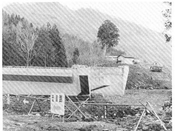
橋梁の架替工事の進む打当地区
