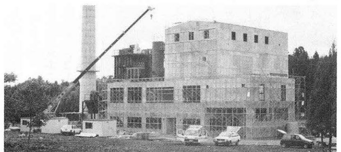
建設中のゴミ処理施設
