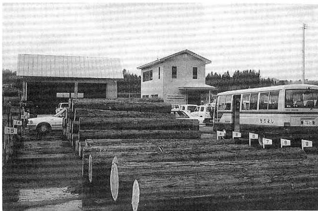
▲完成した「阿仁森吉木材流通センター」
