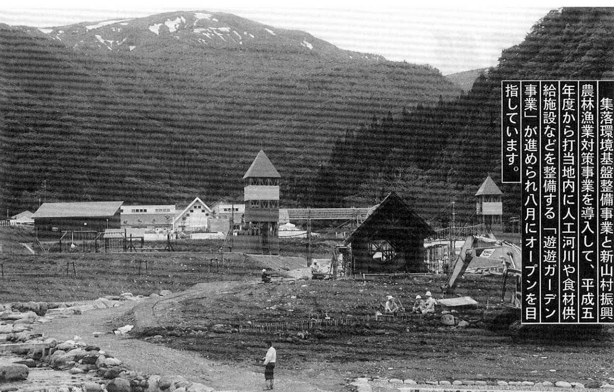
▲ 8月オープンにむけて急ピッチで建設が進められている「遊遊ガーデン」
