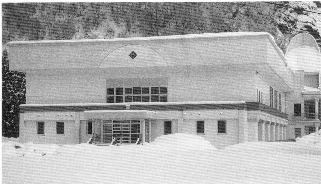
完成した大阿仁小学校体育館
