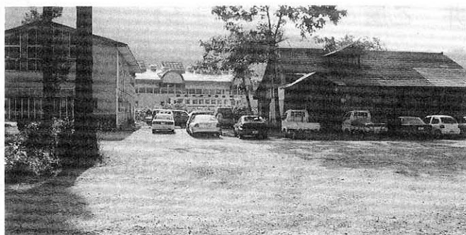
新庁舎建設予定地として交渉が始まる古河阿仁林業所用地
