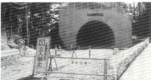
10月から供用開始予定の町道吉田小様線の道路改良工事
