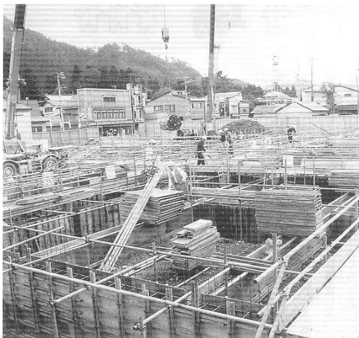
▲現在建設中の庁舎
