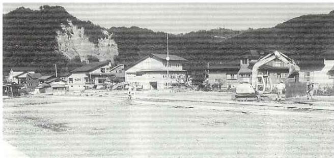
▲造成中の分譲地（幸屋渡地内）
