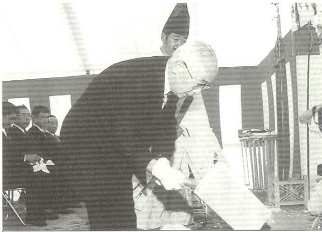
9月 役場庁舎建設工事着工。11月には打当温泉新築工事も着工
