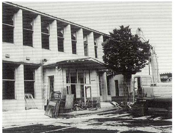
▶解体された旧庁舎
