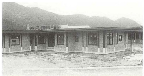
▲建設中の養護老人ホーム
