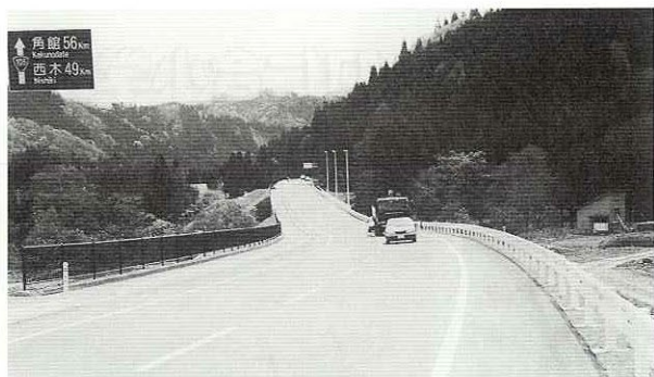
▶ 完成したバイパス
