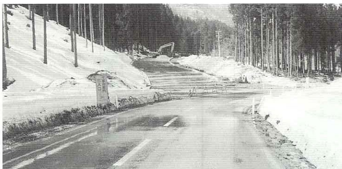
▶供用が間近い笑内バイパス
