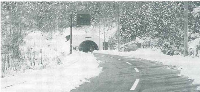
▲完成した榎森トンネル
