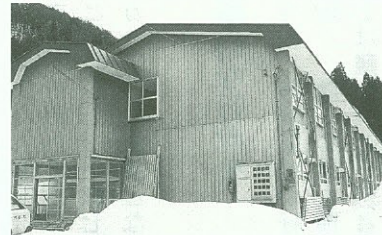
一階を高齢者冬期共同住宅に整備する母子生活支援施設
