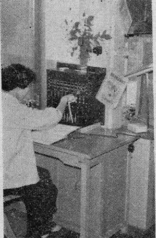
【写真】新設された交換台
