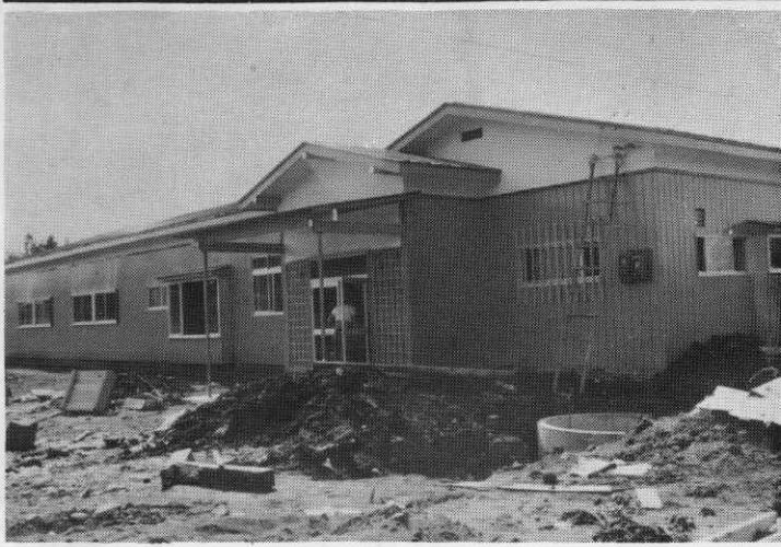
竣工間近の老人憩の家
