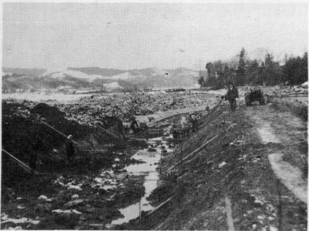
45年度通年施工の工事現場 (道城地内)
