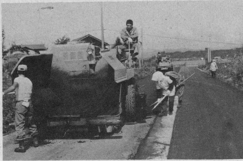
住みよい町づくりの基本は道路の整備から (森吉合川線李岱バイパスの舗装工事)
