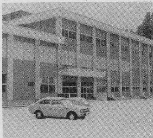
永久校舎に生まれ変わった南小学校
