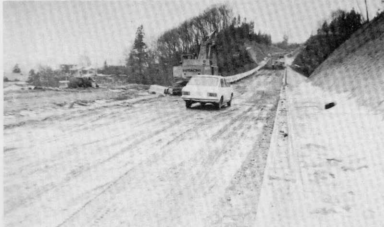
進む生活道路整備。李岱バイパス 工事も急ピッチ (東根田地内)
