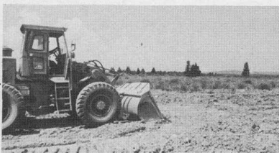
十二月操業にむけて造成作業は急ピッチ。
