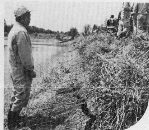
▲緊急排水を行った上杉堤。雨期に入り警戒が必要だ。
