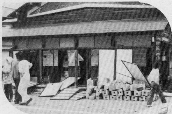
▲戸障子がはずれ、倒壊の不安におののいた。(増沢)
