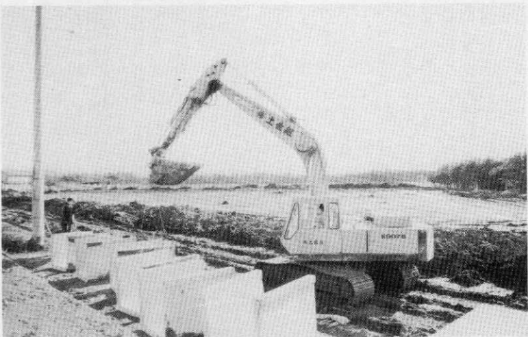
大規模な整地作業に大型機械が走り回る。森吉山を遠望する雄大な景観に、さらに新会社の誘致が待たれている。
