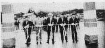
拍手につつまれて 摩当沢線舗装完成 のテープカット。
