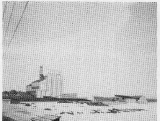
カントリー施設を中心に農業施設群。 今年度は農業総合施設指導センターを建設。
