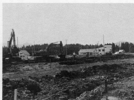
新しい「街」づくりの一角にグラウンド工事が急ピッチ。
