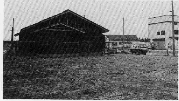
着々進む新築工事
