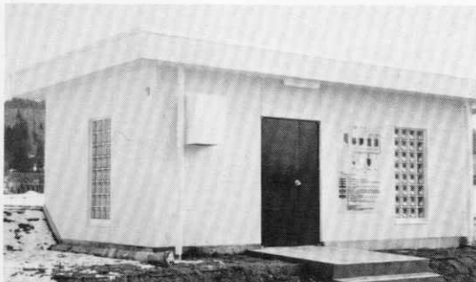
鎌沢集落南端に設置した処理場、ここで生活排水などを浄化処理する。
