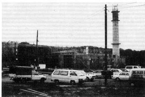
▶大野台農免道路沿（鷹巣町）に建設進む広域ゴミ処理施設
