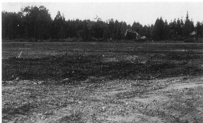
分譲の申込みが開始され、完成をめざして工事も急ピッチ
