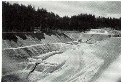
ダムを思わせる ゴミの最終 処分場
