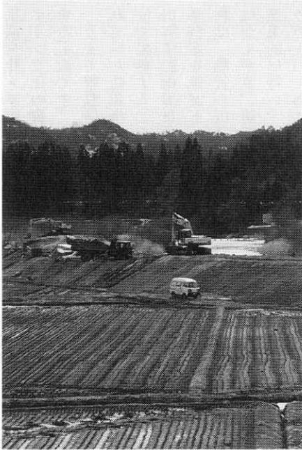
左右両岸で進む小阿仁川改良工事
