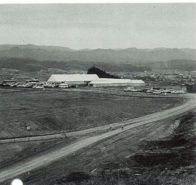
この場所から飛び立つ日を心待ちして 大館能代空港の起工式
