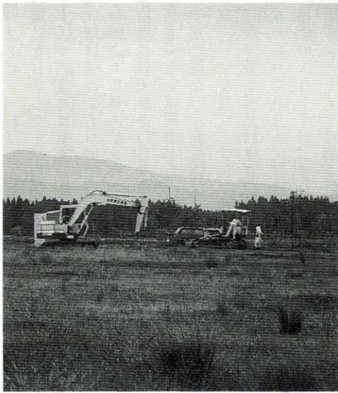
オータムフェスティバルが開かれる北欧の杜公園で進むパークセンターゾーン工事
