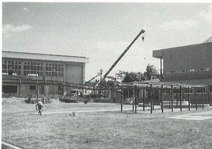
機能的に—そして美しく、のびのびと使える 校舎に仕上げ工事が急ピッチ
