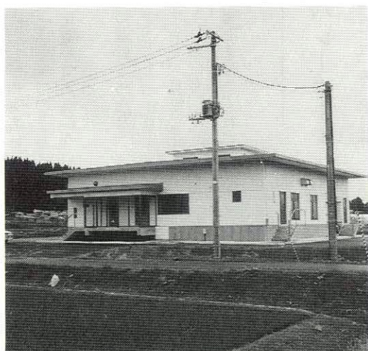
7月から利用が始まる木戸石八幡岱地区の集落排水の処理施設
