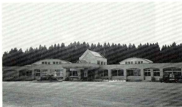
平成六年改築竣工の愛生園に 次いで改築工事が竣工
